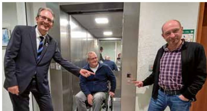
Bürgermeister Dr. Ralf Göck und Bauleiter Chris Oelsner zeigen dem Behindertenbeauftragten Rudi Bamberger den neuen und größeren Aufzug
