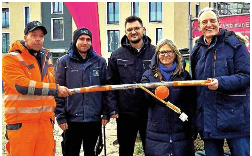
Bürgermeister Dr. Ralf Göck (r.) und Telekom-Regionalmanagerin Ana Pia Engel zeigen zusammen mit S&W-Mitarbeitern ein Bündel Glasfaser-Röhrchen, die auf die Häuser der „Grünen Mitte“ verteilt werden Foto: Verwaltung
