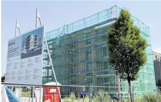
Wenn das Brühler Gemeindefohnhaus in der Albert-Einstein-Straße fertig ist, wird es von einer Photovoltaikanlage gekrönt sein.
