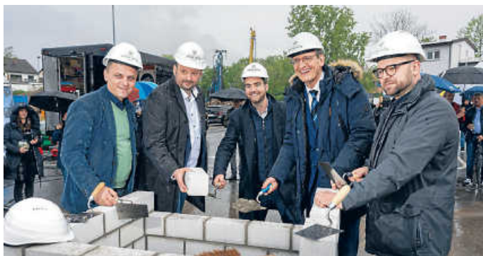
Gazmend Wiedmaier vom Pflegedienst Triebskorn gGmbH, Andreas Metz (Kalkmann Wohnwerte), Nicolas Zimmermann (FWD Hausbau), Bürgermeister Dr. Ralf Göck und Markus Rudek (Baufrosche), v.r.n.l., legen bei der Grundsteinlegung Hand an Foto: Lenhardt
