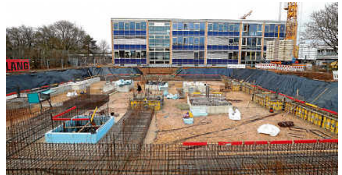
Der Bau im Süden der Schillerschule geht schon gut voran
