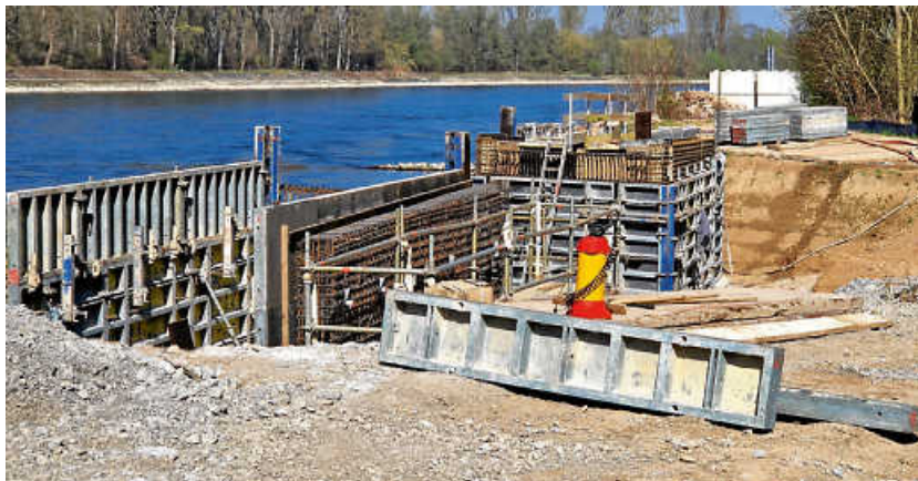
Die Leimbachbrücke wird auf zwei Betonpfeilern liegen und im Sommer fertig sein
