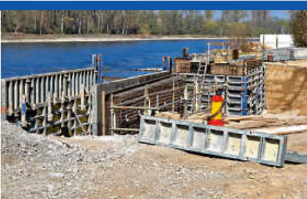
Bau der Leimbachbrücke geht voran
