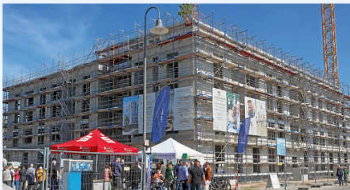
Das Betreute Wohnen zwischen Schrankenbuckel und der neuen Straße „Weixdorfer Ring“ mit seinen vier bis sieben Geschossen steht im Rohbau und soll Ende 2026 bezogen werden
