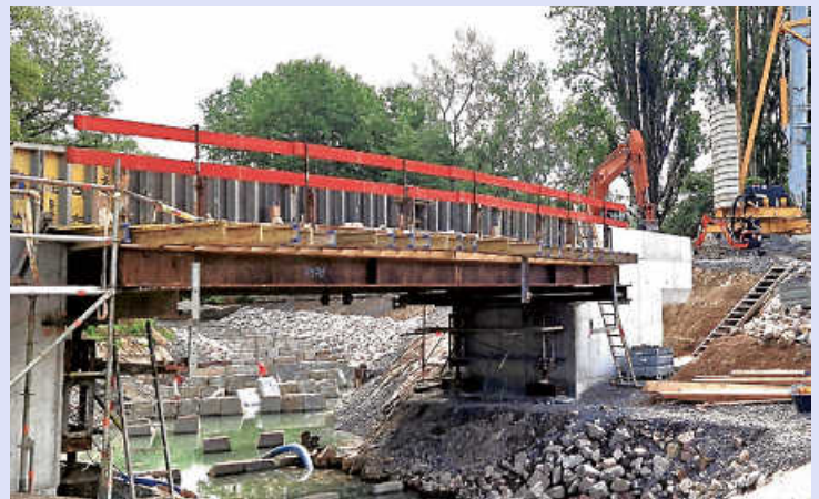
Die Leimbachbrücke wird auf den beiden Betonpfeilern liegen und im Sommer fertig sein
