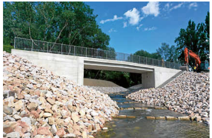
Die neue Leimbachbrücke mit der Fischaufstiegsanlage
