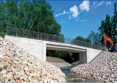
Neue Leimbachbrücke S. 9
