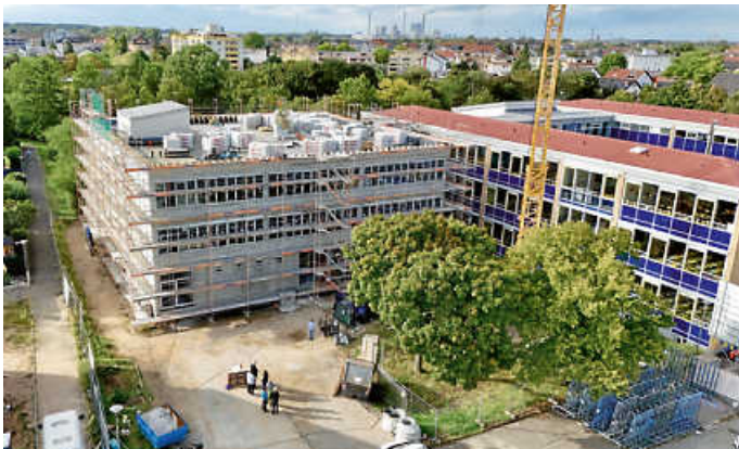
Blick auf den Rohbau
