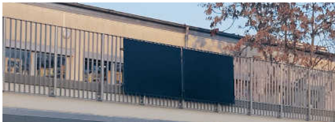
Projekt Balkonkraftwerk an der Dachterrasse der Gemeindebücherei Brühl (Foto: AG Erneuerbare Energien)
