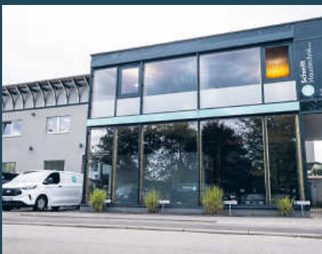
In diesem Firmengebäude der Schmitt Haustechnik HSK GmbH heißt es künftig „Jetzt alles aus einer Hand“.
