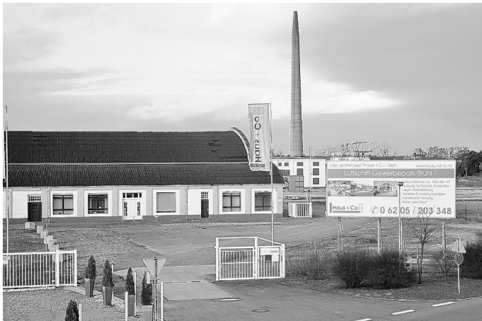
Blick auf den wiederbelebten Schütte-Lanz-Gewerbepark
