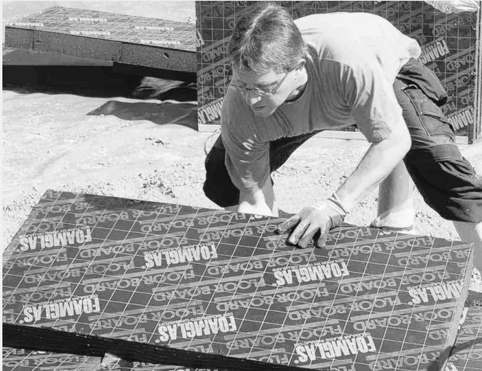
Die geschlossenzelligen Platten nehmen überhaupt keine Feuchtigkeit auf. Wärmebrücken entstehen somit gar nicht erst. Das Klima im Raum bleibt angenehm warm.
