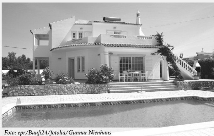
Foto: epr/Baufi24/fotolia/Gunnar Nienhaus
