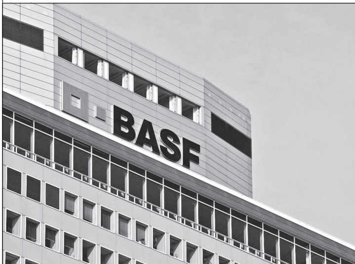
Die BASF in Ludwigshafen baut eine neue Anlage Foto: BASF
