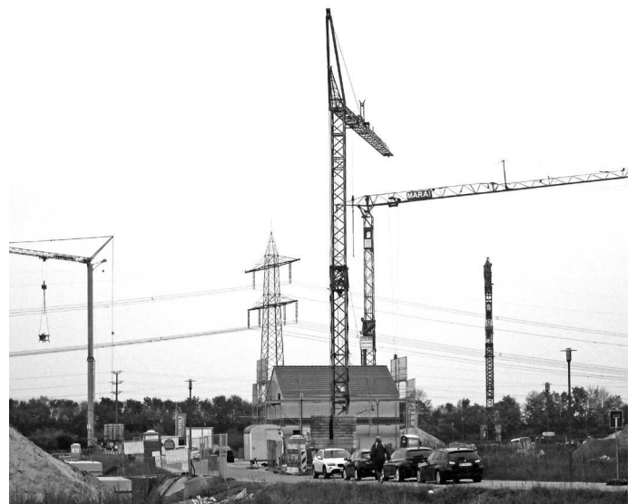
Schon bei der Freigabe standen die ersten Baukräne, die ersten Bewohner werden im Frühjahr 2015 einziehen.
