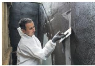
des Gebäudes abgedichtet“, erklärt Jürgen Münch von der Firma ISOTEK, die spezialisiert auf die Beseitigung von Feuchtigkeits- und Schimmelschäden ist. Die betroffene Außenwand muss freigelegt und das Erdreich für den Zeitraum der Sanierung entfernt werden. Und das geht in Frühjahr und Sommer natürlich leichter, als bei einem gefrorenen Boden im Winter.
