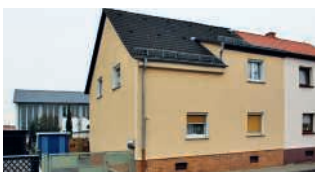
1- bis 2-FH in Brühl-Rohrhof
