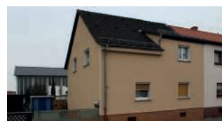
1- bis 2-FH in Brühl-Rohrhof
