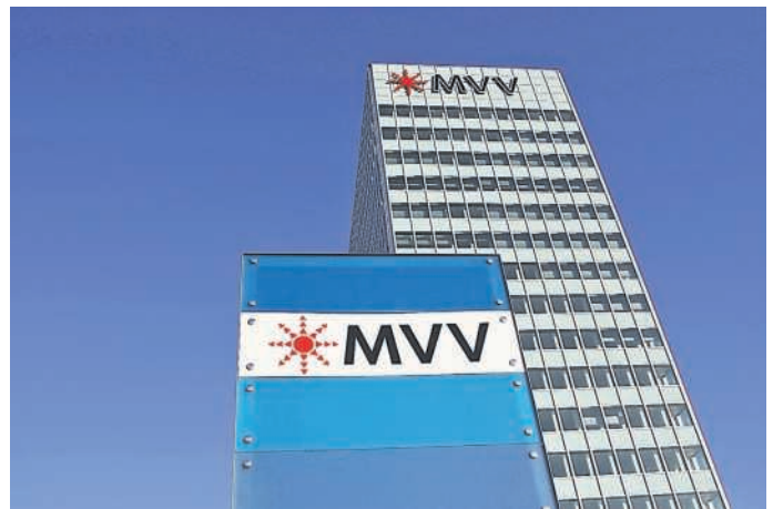
MVV-Zentrale in Mannheim.
