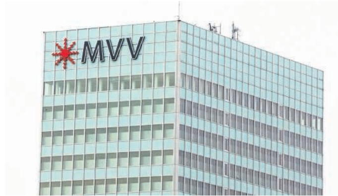
MVV Energie-Zentrale in Mannheim
