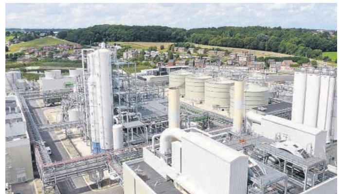
Die Bioethanolanlage der nächsten Generation in Wanze, Belgien, ist die modernste in Europa. Foto: CropEnergies AG
