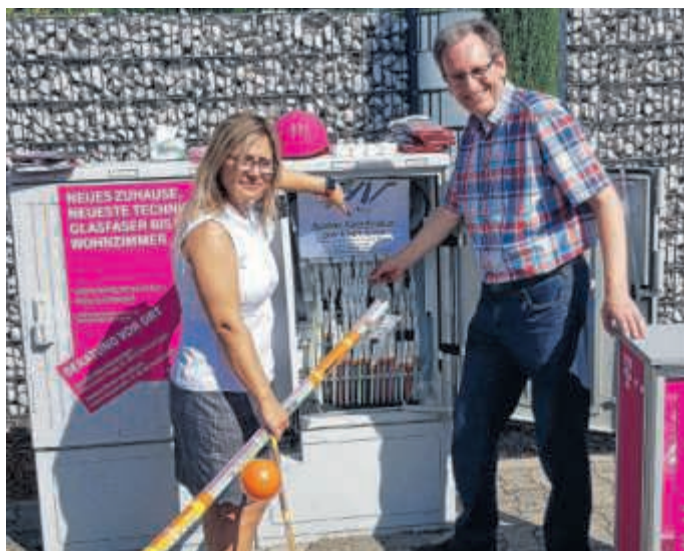
„Glasfaserausbau 2019, Ana Pia Engel (links) und Bürgermeister Dr. Ralf Göck vor einem der Verteilerkästen Foto: Gemeinde
