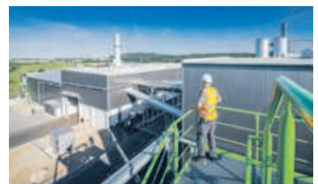
In der Sinsheimer Bioabfallvergärungsanlage der AVR entsteht Frischkompost und Biogas
