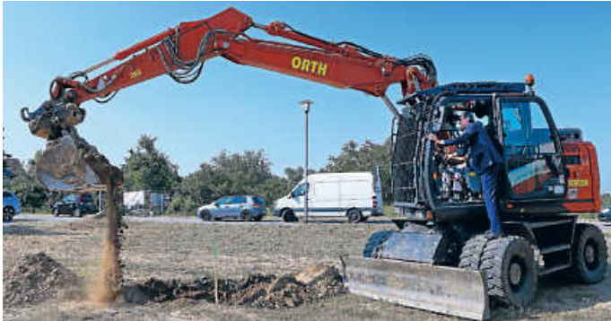
Mit einem modernen Kleinbagger der Firma Orth schichtete Bürgermeister Dr. Ralf Göck den Erdhaufen für den Spatenstich auf
